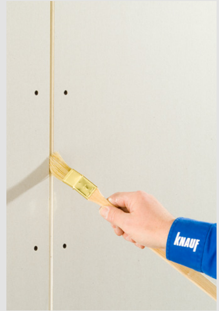
Application of Knauf Tiefengrund
