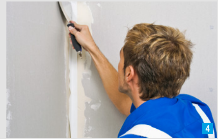
Press in (bed) Knauf Kurt joint tape
