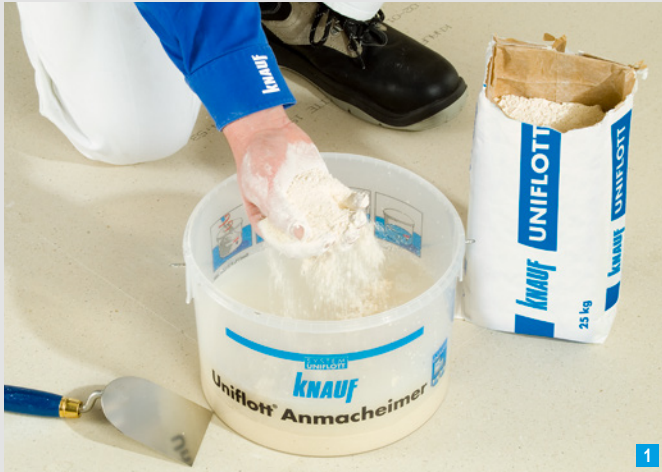
Sprinkling of Knauf Uniflott
