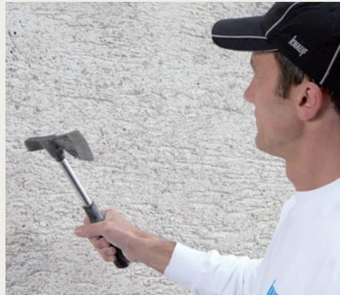
Bei leichtem Anklopfen des Untergrundes können Hohlstellen festgestellt werden. Diese sind zu entfernen und mit artgleichem Material zu schließen.
