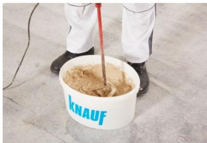
Mélangez 20 kg de Sandstein-Design Kleber avec environ 4,8 litres d'eau propre et remélangez après 5 minutes. La durée d'ouvrabilité comporte env. 60 minutes. Température de mise en œuvre d'au moins +10 °C jusqu'à +30 °C. Ne mélangez que la quantité de colle que vous serez en mesure d'appliquer pendant la durée d'ouvrabilité.
