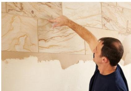
Lissez les joints avec les doigts, un pinceau ou un outil approprié immédiatement après le collage de Sandstein-Design Wandplatte. Rebouchez les joints complètement avec Sandstein-Design Kleber.
