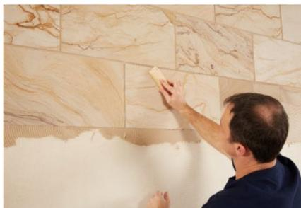
Faites fermement pression sur la plaque en vous servant de Sandstein-Design Werkzeug. Évitez impérativement la formation des creux. De minuscules grains de sable peuvent se détacher de la surface en faisant pression et en lissant la plaque avec l'outil de montage.
