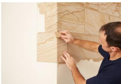
Lissez d'abord Sandstein-Design Wandplatte chauffée sur une face du mur avec Sandstein-Design Werkzeug, puis lissez l'autre zone de l'angle en commençant de l'autre côté de sorte à éviter la formation de plis et creux.
