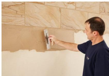
Après le gâchage de Sandstein-Design Kleber, appliquez avec une taloche crantée de 6 à l'extérieur ou une taloche crantée de 4 à l'intérieur sur toute la surface du support, puis lissez avec un peigne à colle.
