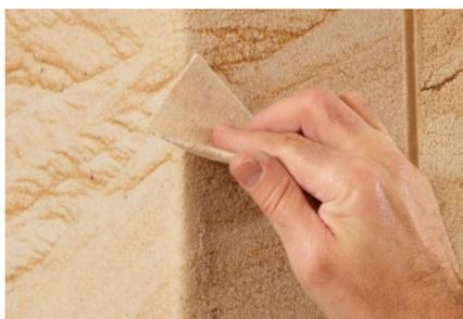
Vous pouvez éliminer les restes de colles, défauts de planéité ou fissures dues au modelage avec une chute de Sandstein-Design Wandplatte ou procéder au garnissage requis avec le sable à polir se produisant pendant l'apprêtage consécutif.
