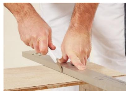
La coupe à dimensions de la taille ou forme souhaitée des Sandstein-Design Wandplatten s'effectue facilement avec un couteau. La coupe s'effectue en séparant le tissu au verso de Sandstein-Design Wandplatte.
