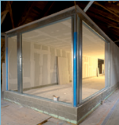
Leichte Bauweise aus Teleskop-Stützen und Standard-Profilen
