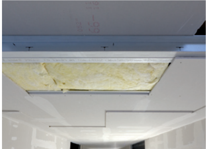
Deckenausbildung mit freigespannten CW-Profilen und F90-Beplankung mit Fireboard
