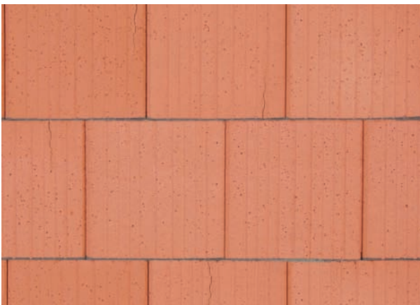
Bild 12: Ziegelmauerwerk mit Trocknungs- oder Brennrissen
