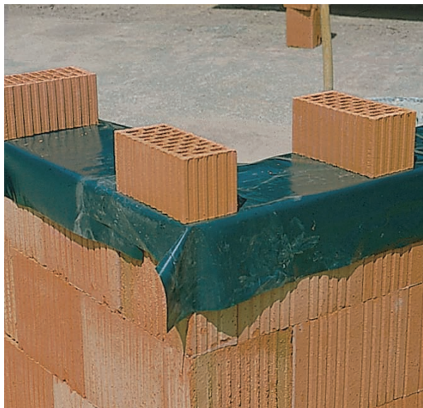
Bild 11: Abdeckung von Mauerkronen
