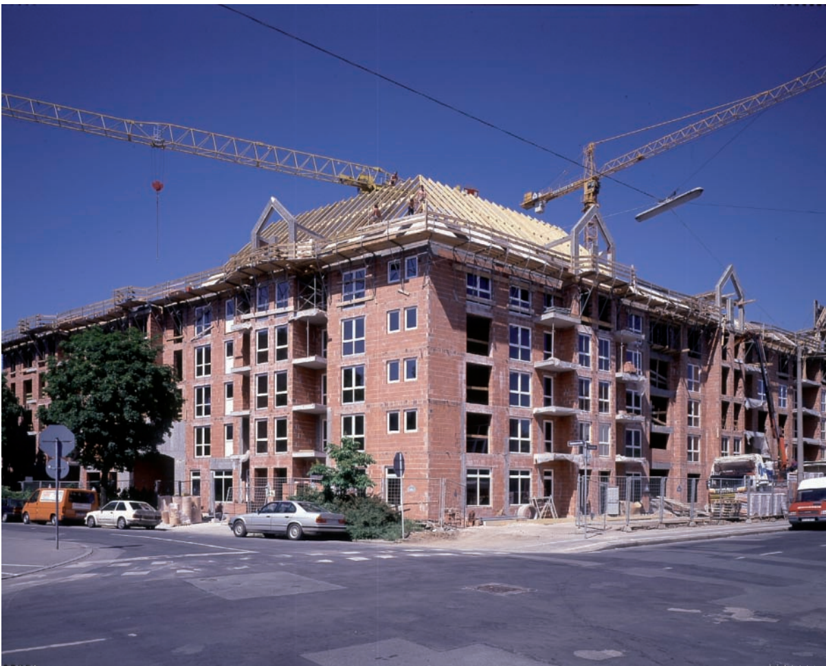
Bild 2: Homogenes Ziegelmauerwerk
