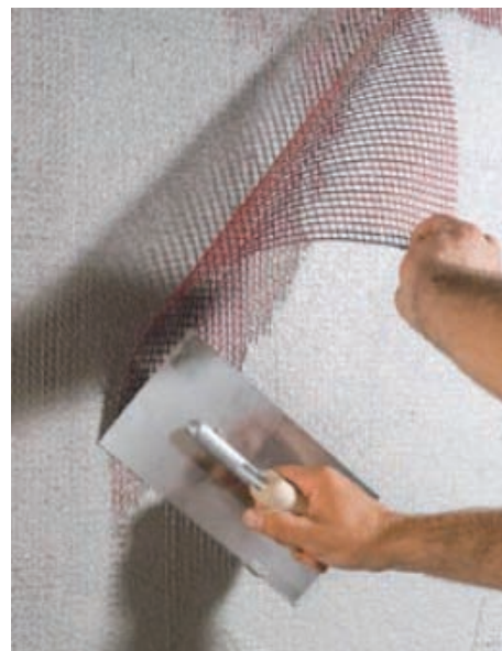
Bild 8: Armierungsputz mit Gewebeeinlage
