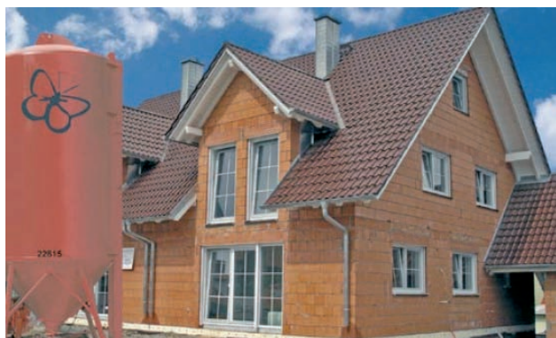
Bild 4: Homogener Putzgrund
