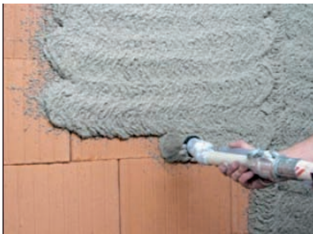
Bild 14: Auftrag des Unterputzes auf Planziegelmauerwerk
