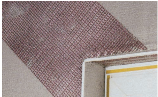
Bild 7: Armierungspfeil an Öffnungsecken
