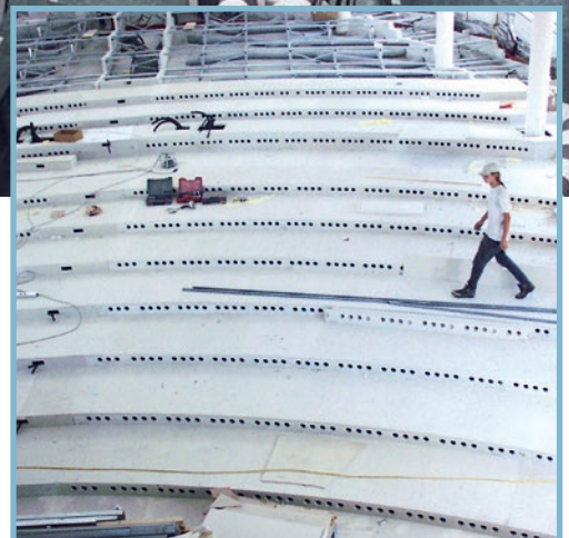
Einbau eines GIFAfloor LBS Systems in einen Konzertsaal mit Zuluführung.
